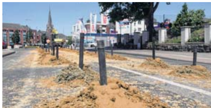
Die Umbauarbeiten des Eickener Kreisels haben begonnen. FOTO: DETLEF ILGNER
